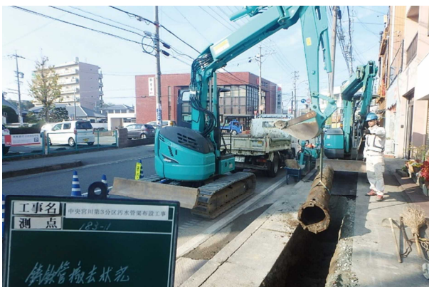
老朽管撤去状況
